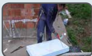
Applicazione della schiuma poliuretanica sulle lastre RXZ
