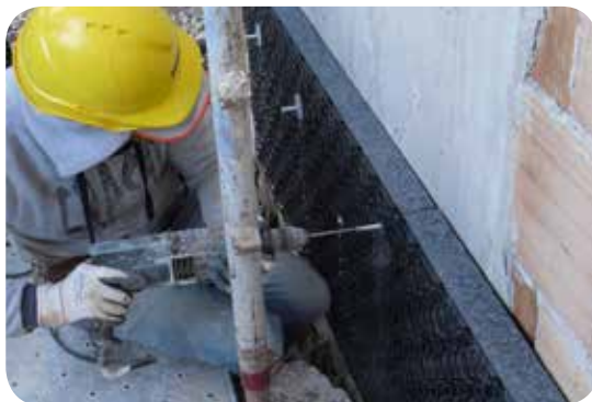
Foratura delle lastre
