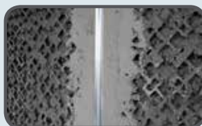
Posizionamento delle guide per determinare lo spessore dell'intonaco RXM2
