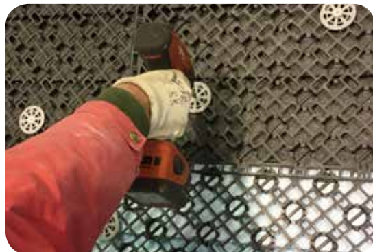
Fissaggio meccanico delle lastre con tasselli
