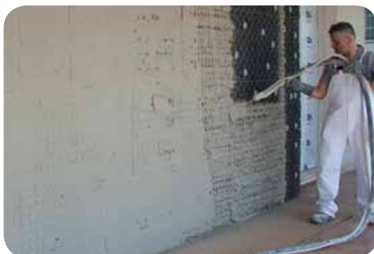
Applicazione dello strato di intonaco
