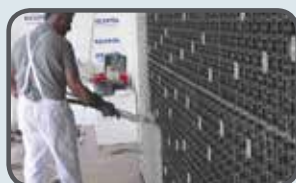
Applicazione meccanizzata dell'intonaco aggrappante RXM1
