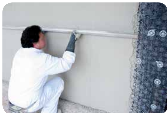
Staggiatura e calibratura dell'intonaco
