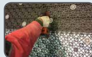
Posizionamento, foratura e fissaggio delle lastre RXL
