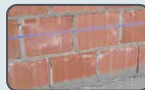
Tracciatura della linea di livello
