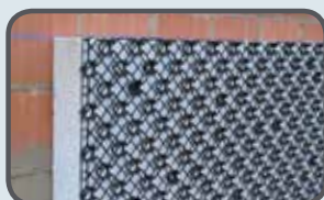
Posizionamento della prima lastra RXZ
