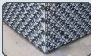
Posizionamento, foratura e fissaggio della lastra d'angolo RXZ
