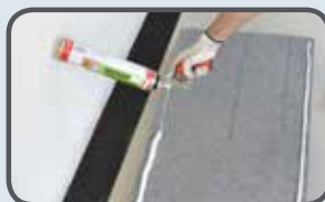
Applicazione della schiuma poliuretanica sulle lastre RXL
