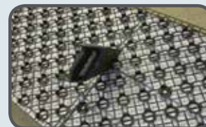
Ridimensionamento della lastra RXZ in prossimità dell'angolo
