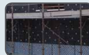
Come deve presentarsi la parete prima dell'applicazione dell'intonaco aggrappante RXM1
