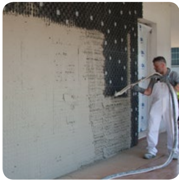
Applicazione dello strato di intonaco
