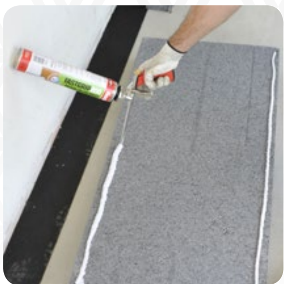
Applicazione schiuma di fissaggio
