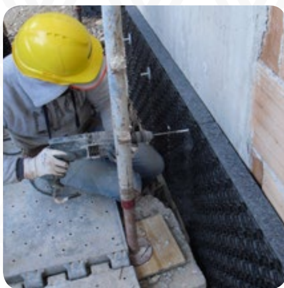
Foratura delle lastre
