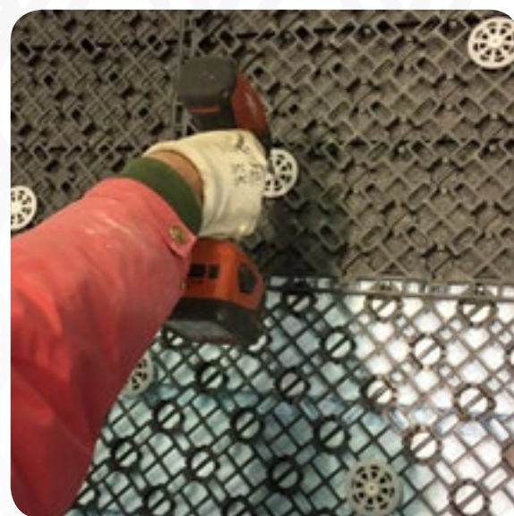
Fissaggio meccanico delle lastre con tasselli
