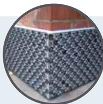
Posizionamento, foratura e fissaggio della lastra d'angolo RXZ
